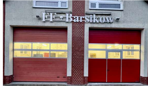
Die Außenseite: Das Bestandstor (links) und das neue Tor (rechts)
