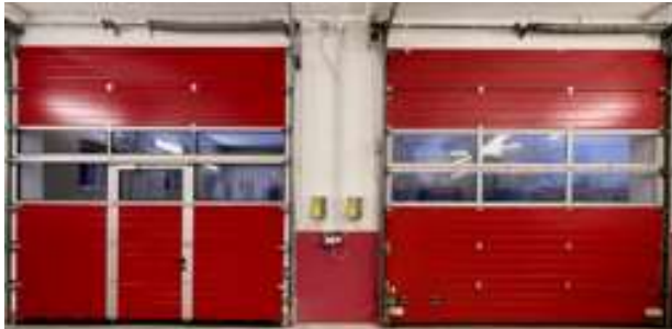
Die Innenseite: Das neue Tor (links) und das Bestandstor (rechts)
