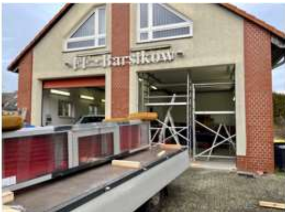
Entfernung des bestehenden Tores
